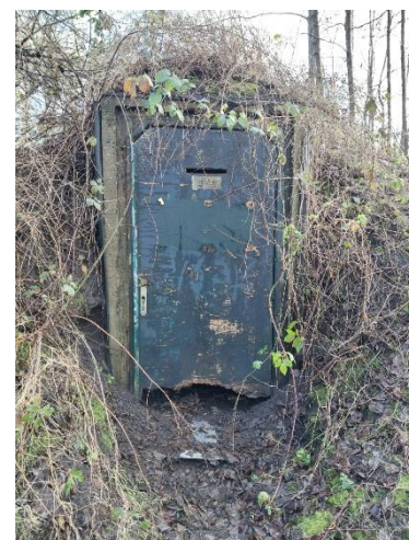
Deur Verkeerspark met kapotte onderzijde (foto: Kathelijn De Maeijer)
