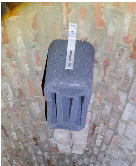
Eén van de nieuwe gewelfstenen. (fotos Evert-Jan Slot)
